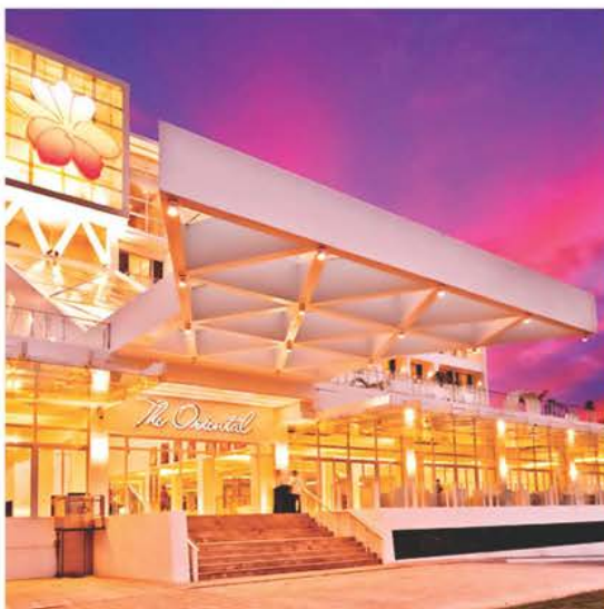
ガラス張りの美しい外観
